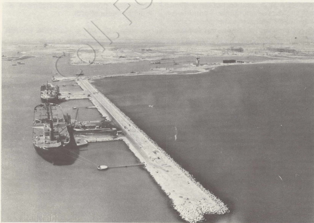
Au premier plan, digue pétrolière, au fond installations sidérurgiques.
